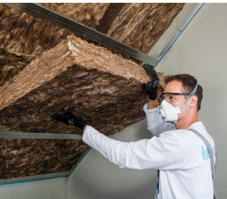
Obr. 1 - Minerální izolanty jsou klíčovým materiálem při zateplení šikmých střech
